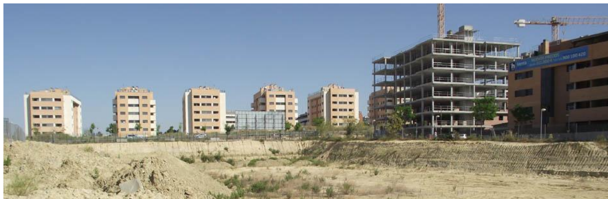
Crecimiento en tercera periferia durante la última década. Mairena del Aljarafe (Sevilla), 2012
